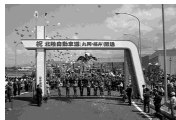
▲北陸自動車道(丸岡—福井オープン) 昭和50年 67601
